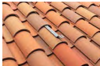
Dettaglio: installazione sotto tegola
