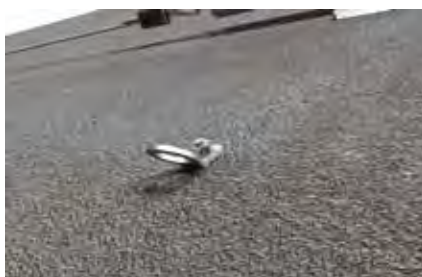
Sistema puntuale di aggancio su copertura a shed
