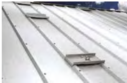
Sistema di ancoraggio su lamiera grecata
