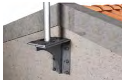
Dettaglio: fissaggio palo di estremità
