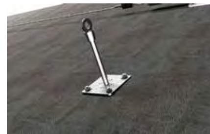
Palo deformabile su tetto a shed
