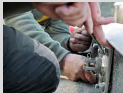
Fissaggio di piastra verticale intermedia
