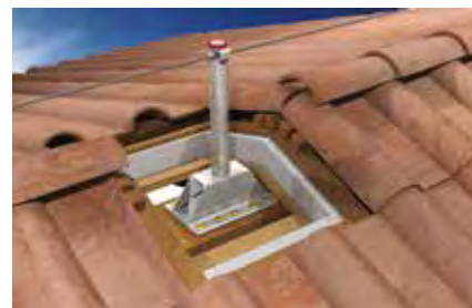
Palo intermedio su copertura inclinata
