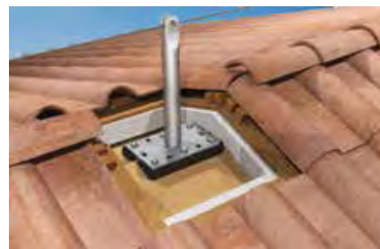
Palo intermedio su copertura inclinata
