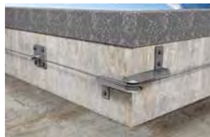
Linea flessibile verticale su parapetto di bordo
