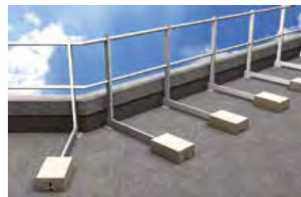
Dettaglio: sistema di zavorra del parapetto
