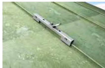
Dettaglio: punto di ancoraggio PSS A
