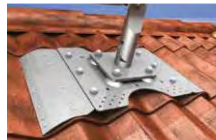
Dettaglio: fissaggio della piastra
