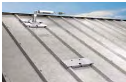
Sistema di ancoraggio su pannelli coibentati
