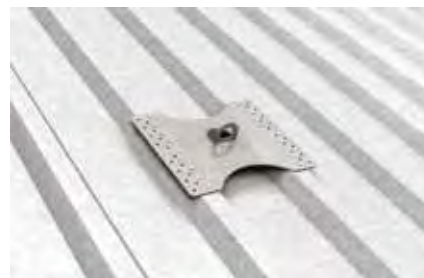
Dettaglio: fissaggio del punto di ancoraggio PGC A
