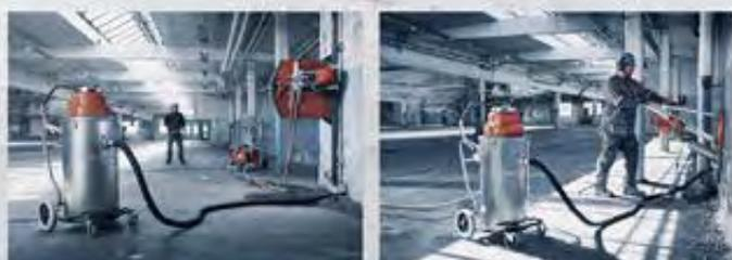
Il taglio/foratura a umido lega la polvere con acqua direttamente alla fonte. Il collettore di fanghi collegato a un aspira-fanghi mantiene pulito il posto di lavoro.
