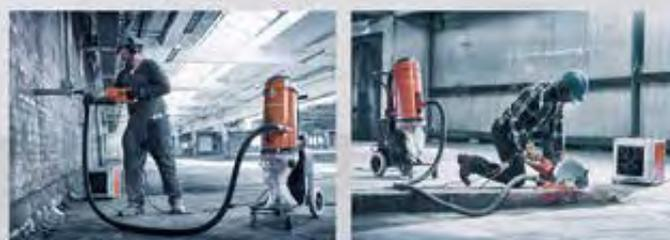
Il taglio/foratura a secco con un dispositivo di raccolta della polvere integrato cattura la polvere direttamente alla fonte. Un aspiratore di polvere con flusso d'aria appropriato e la capacità idonea per l'applicazione, dotato anche di filtri HEPA, si occupa della polvere. L'aria circostante viene filtrata attraverso un purificatore dell'aria/scrubber portatile 6 - 10 volte /all'ora.
