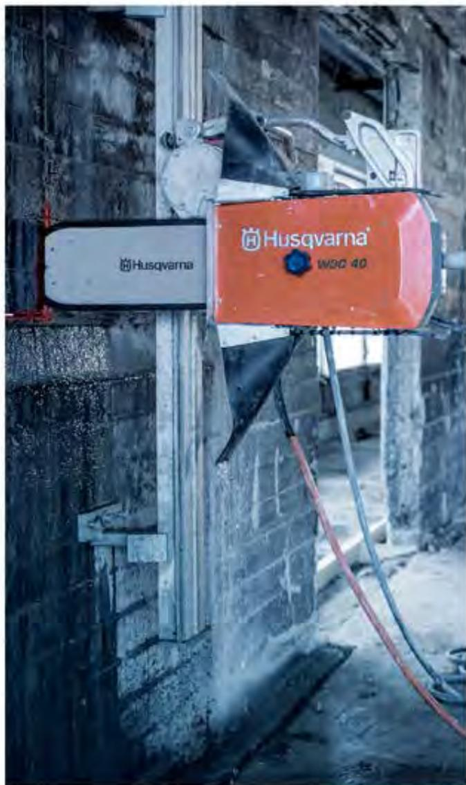
Husqvarna WSC 40 è un accessorio robusto unico nel suo genere in grado di convertire la WS 482 HF Husqvarna e la WS 440 HF dal taglio con disco al taglio con catena. Ideale per tagliare in modo efficace e preciso gli angoli e le piccole aperture senza sovratagli. Si installa facilmente sulla testa di taglio e si utilizza senza riposizionare il binario.
