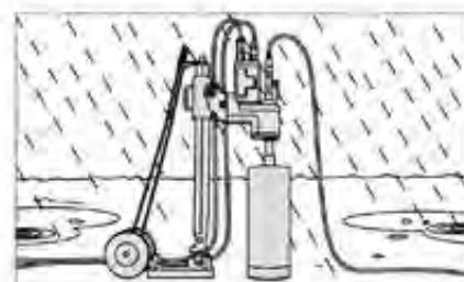
Carotaggi in situazioni difficili.
