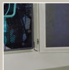
Porte ispezione con doppia battuta e guarnizione ermetica
