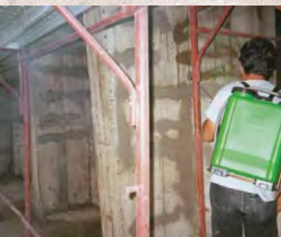
17 Soluzioni rialcalinizzanti e anticorrosive
