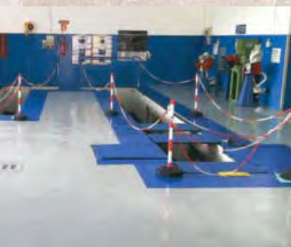
16 Pavimenti in calcestruzzo e in resina
