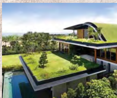
25 Bioedilizia, bioarchitettura e green building
