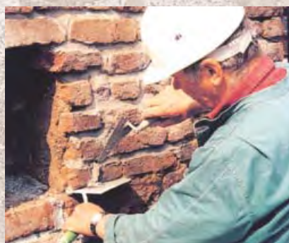
24 Recupero e risanamento murario
